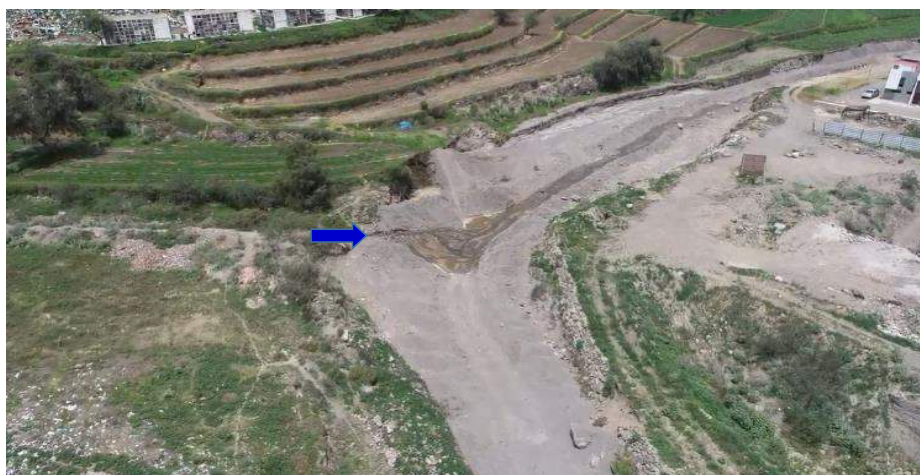
IMAGEN 02: SE OBSERVA EL FIN DEL TRAMO COLMATADO AGUAS ABAJO CON CULTIVOS EN LA MARGEN DERECHA QUE SE UNE A LA QUEBRADA S/N SE REQUIERE DE MURO DE CONCRETO PARA PROTECCION
