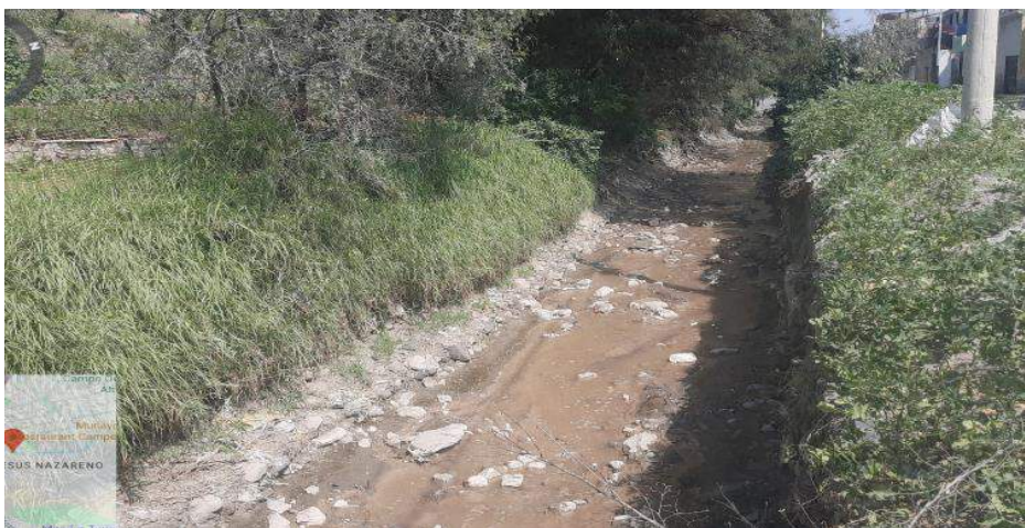
IMAGEN 01: SE OBSERVA EL TRAMO COLMATADO, PARA CONSTRUCCION DE MURO DE CONCRETO
